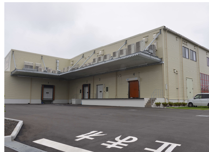
セントラルキッチン 狭山工場 （2019年 竣工）
