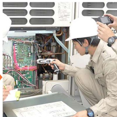
設備点検保守
